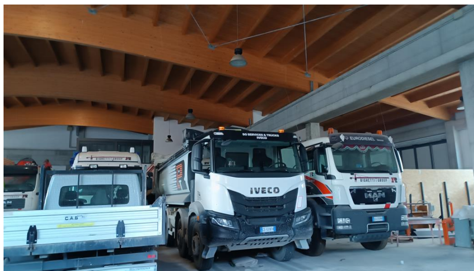
Fig. 11 – Foto interna in corrispondenza del vano a deposito.
