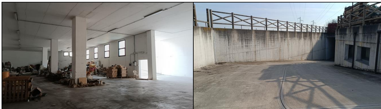
Fig. 16 – Foto interna del magazzino interrato (a sinistra) e della rampa di accesso (a destra).
