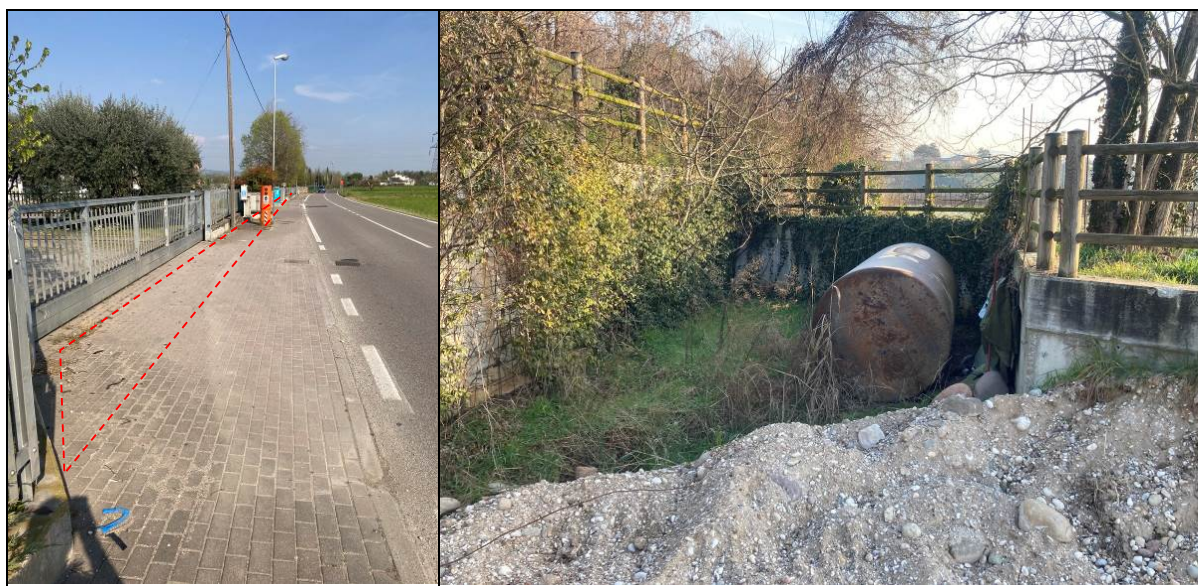
Fig. 18 – Foto dell'Immobile C" (a sinistra) e dell'Immobile D" (a destra).
