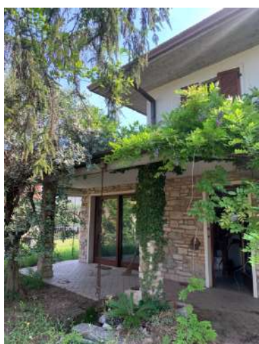
Vista esterno portico d'ingresso
