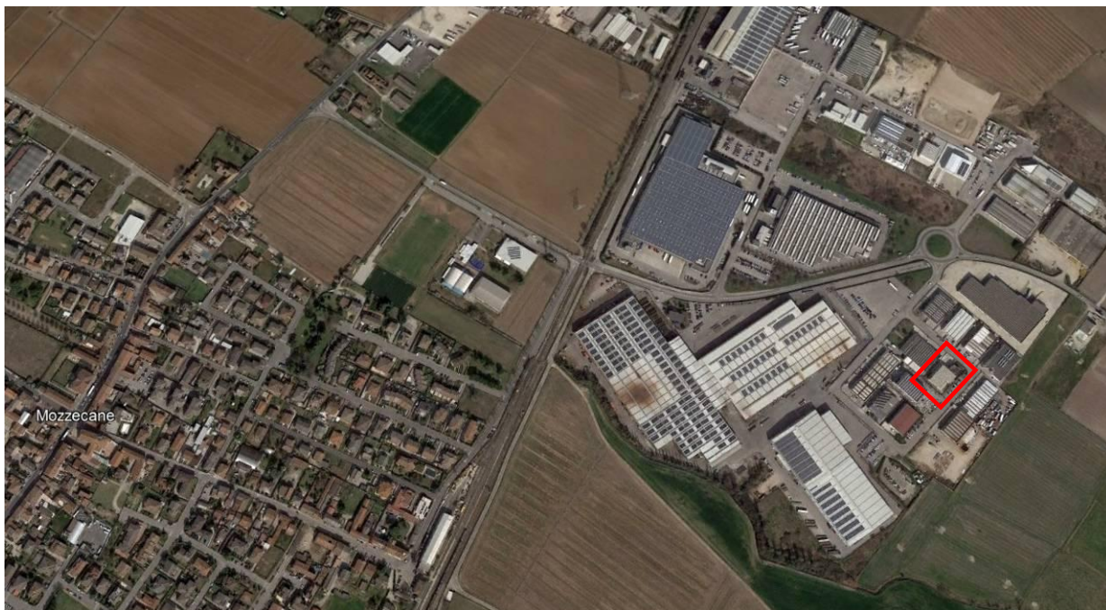
Fig. 1 – Foto aerea dell'area attorno al capannone
