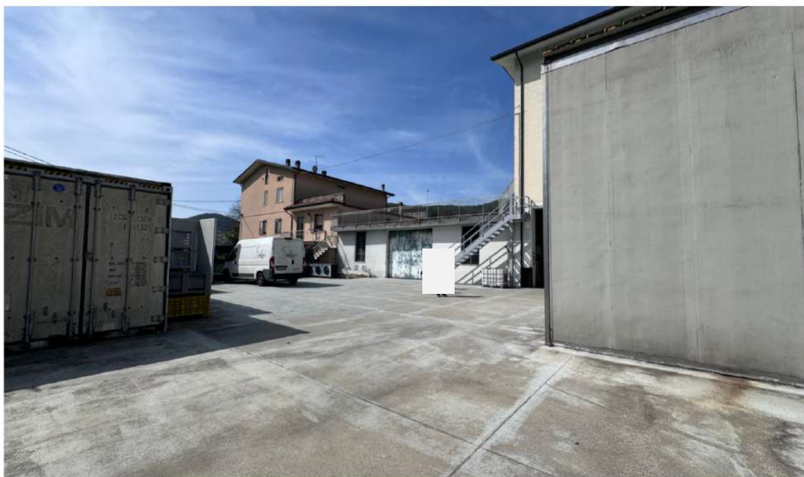
FOTO 4 - Corte (non oggetto di esecuzione) - accesso carrabile ai beni sub. 6 e sub 7
