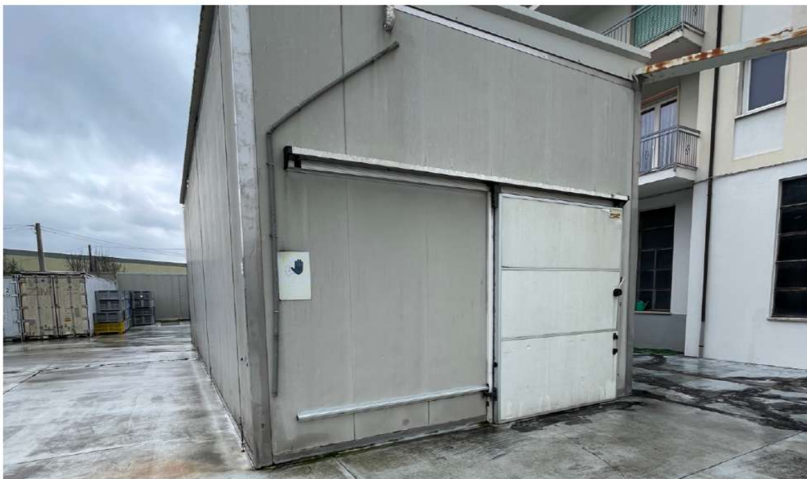
FOTO 6 - Corte (non oggetto di esecuzione) - cella (immobile abusivo)
