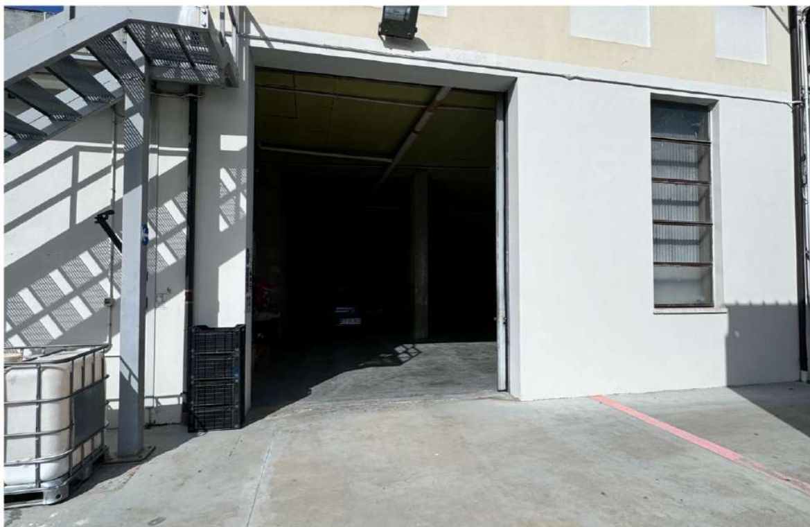
FOTO 3 - Ingresso sub 7 e cantina
