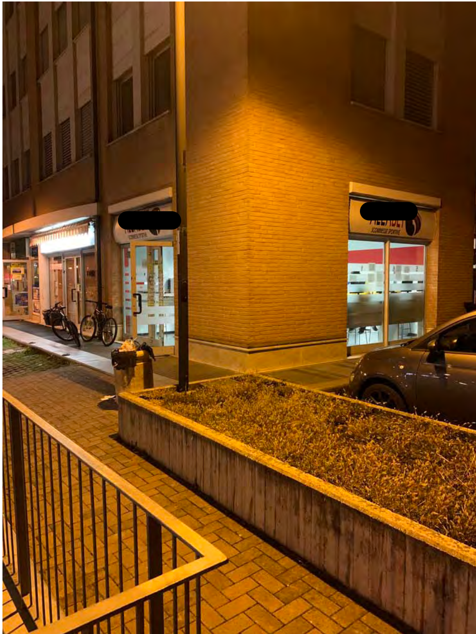
Foto 1. Prospetto Nord-Est e prospetto Nord-Ovest.
