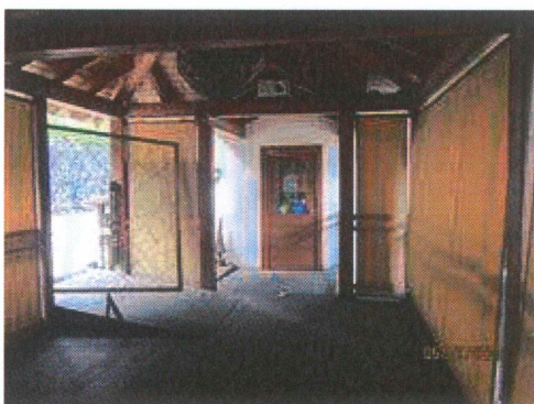
tettoia e ingresso bar
